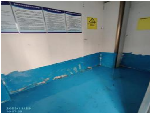
危废库地面防渗
