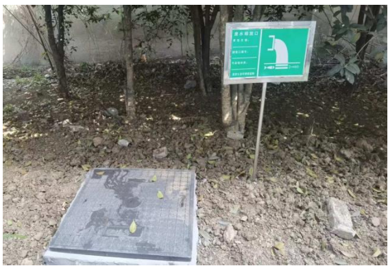
污水总排口 DW001
